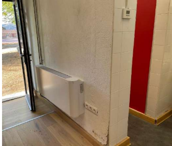
Foto después de la actuación
